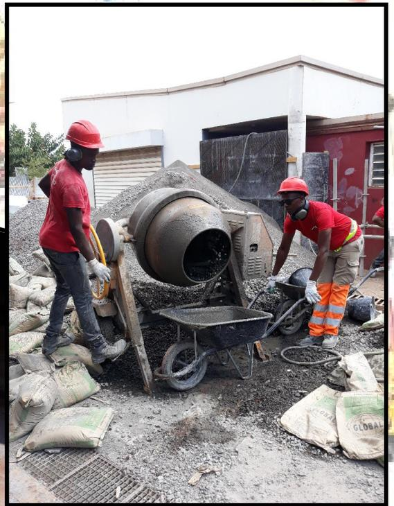
*Fabrication et coulage du béton de propreté dans les fondations*
